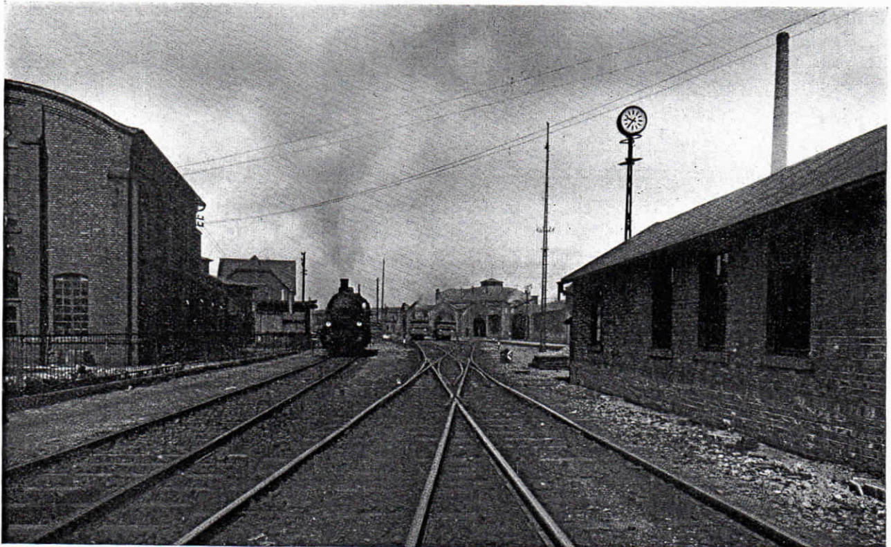
Abb. 26. Freistehende doppelseitige Normalzeit-Nebenuhr, Hauptbahnhof Saarbrücken, Betriebs-Inspektion II
