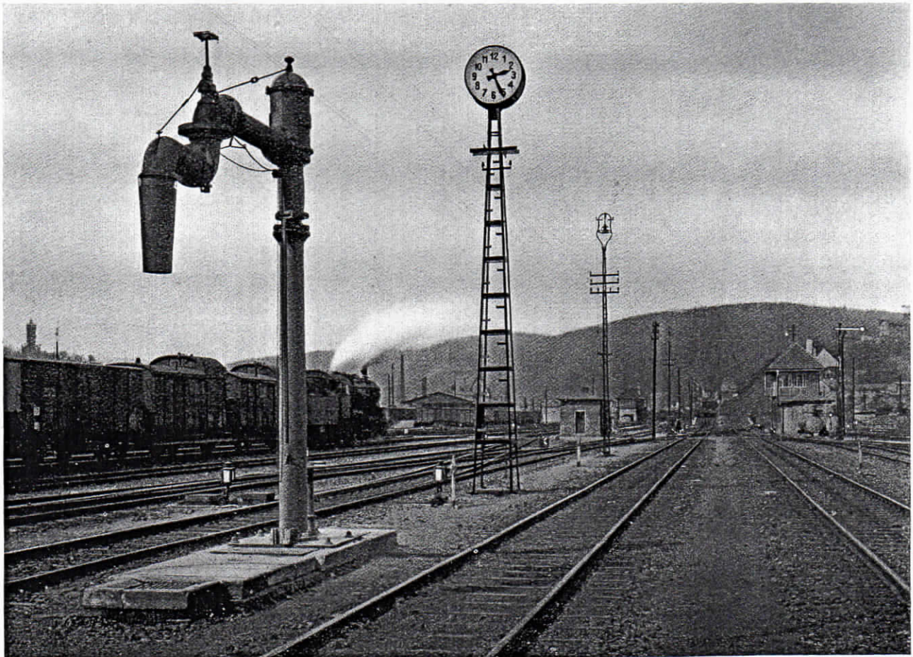
Abb. 25. Freistehende Außenuhr Bahnhof Dillenburg
