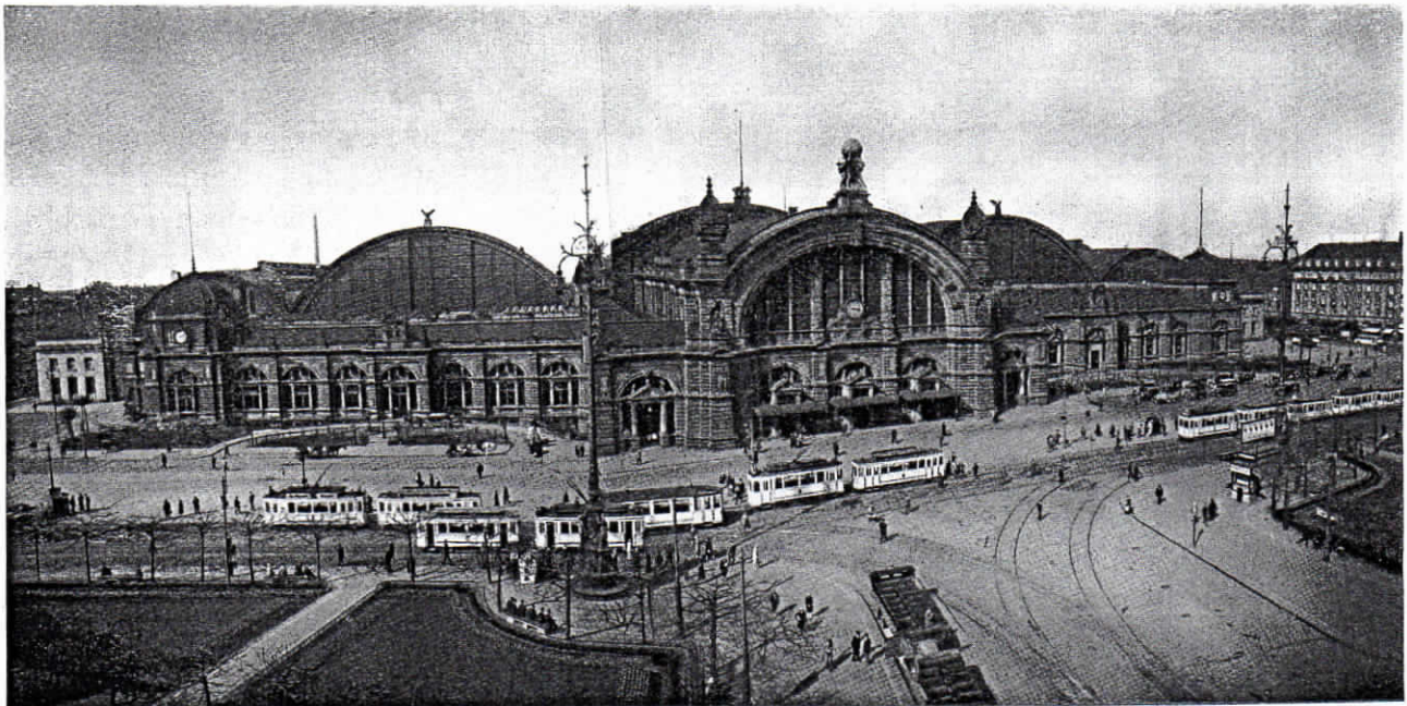
Abb. 1. Empfangsgebäude Hauptbahnhof Frankfurt a. M.
