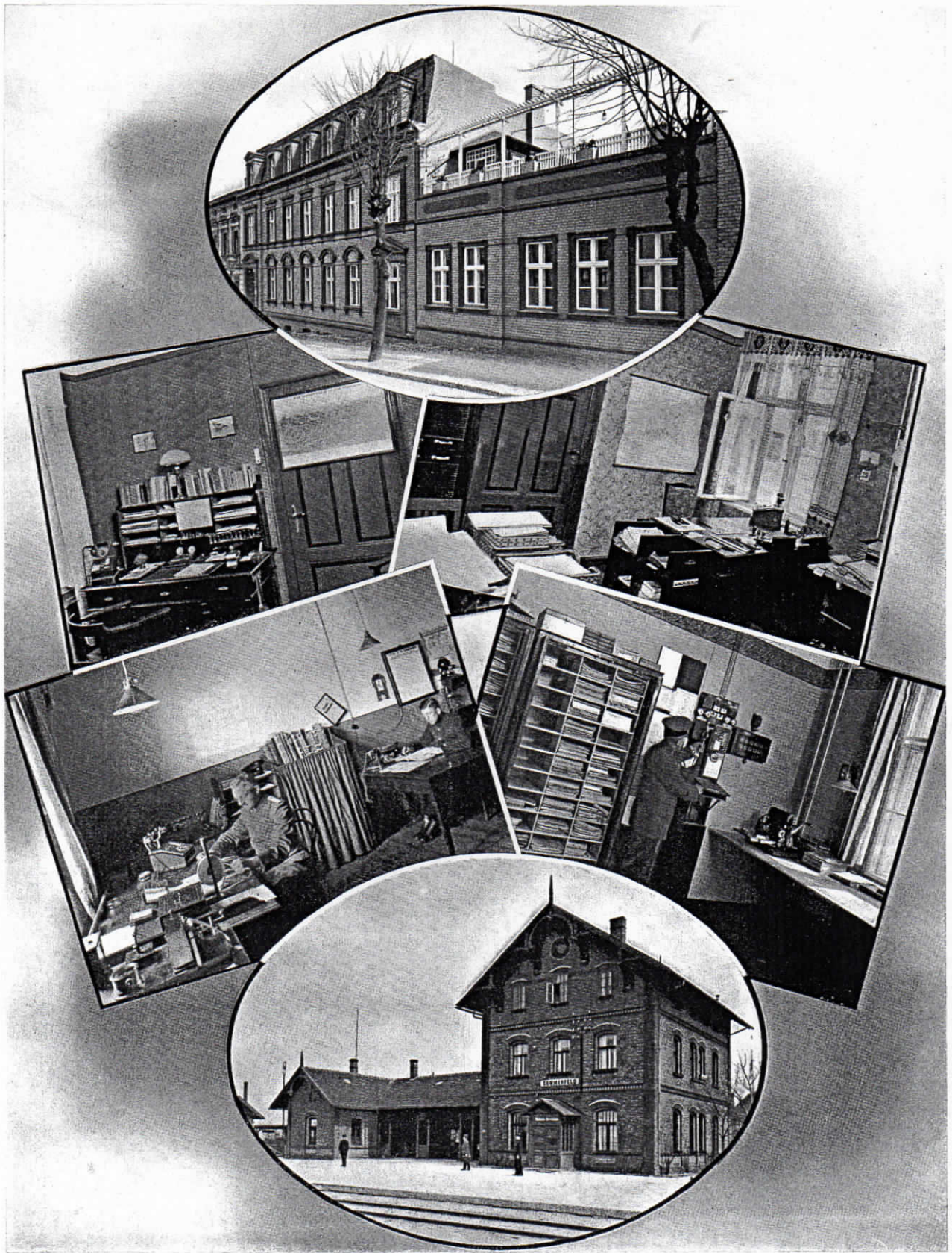
Abb. 14. Direktionsgebäude der Lausitzer Eisenbahn in Sommerfeld / Abb. 15—18 Arbeitszimmer mit „Fuld“-Spezial-Fernsprechapparaten / Abb. 19. Stationsgebäude Sommerfeld
