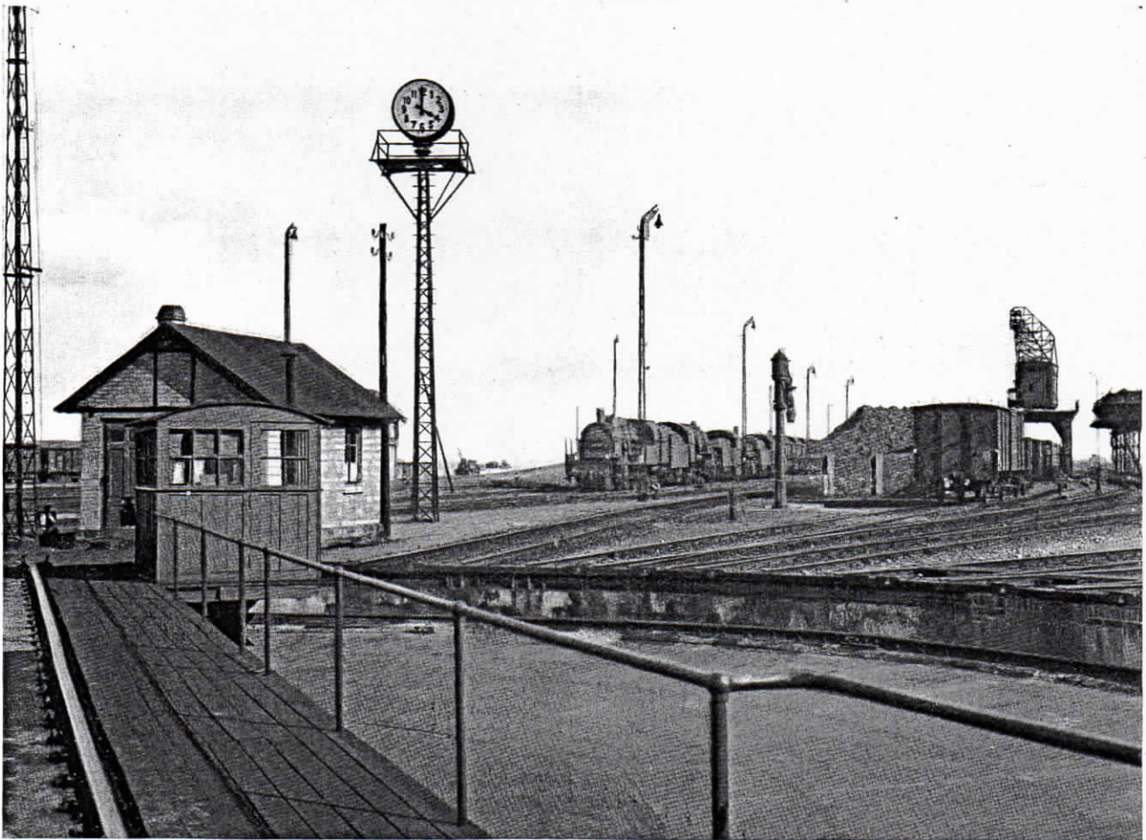
Abb. 31. Freistehende Nebenuhr an der Drehscheibe des Bahnhofs Friedberg
