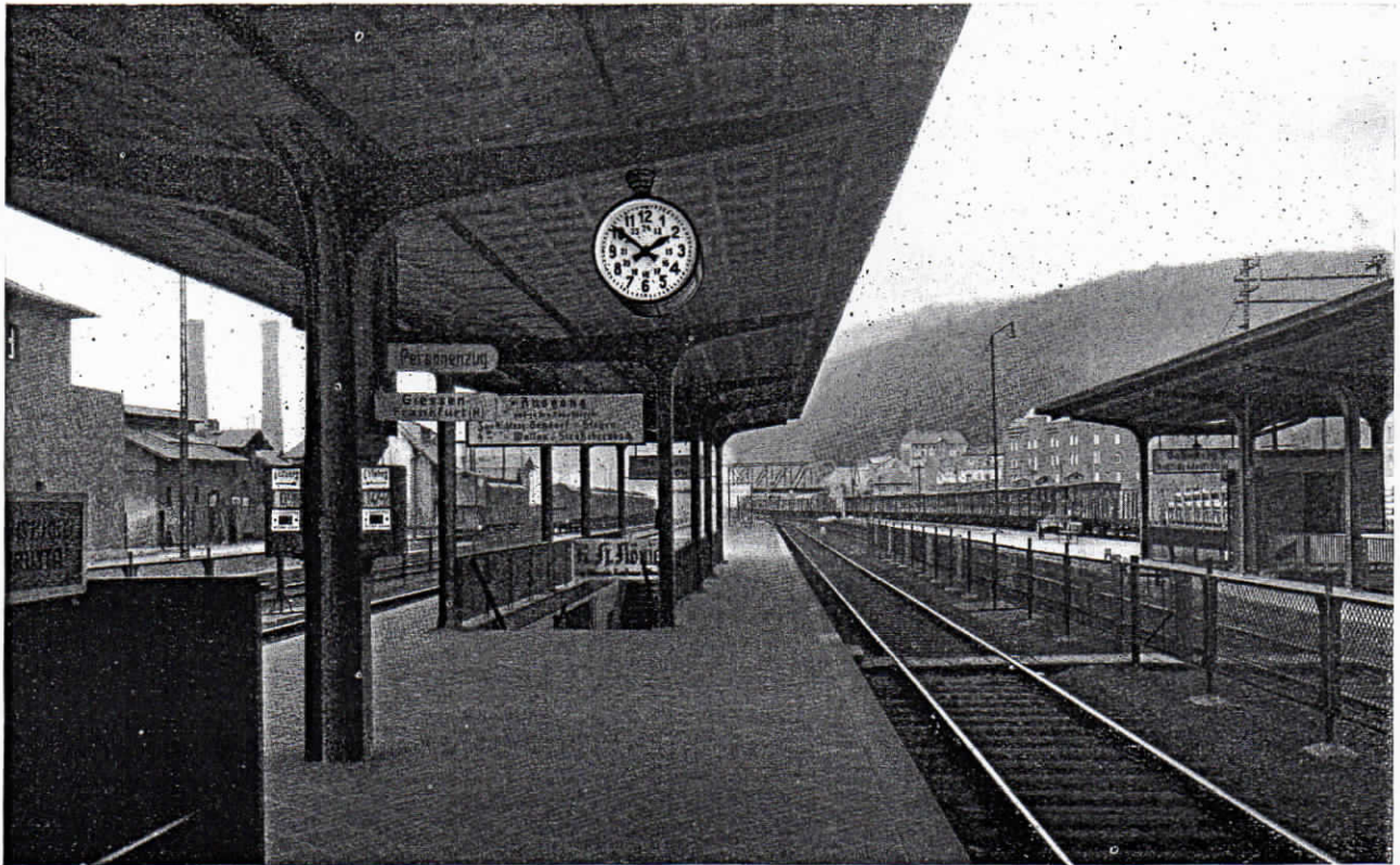
Abb. 22. Nebenuhr unter dem Bahnsteighallendach Bahnhof Dillenburg
