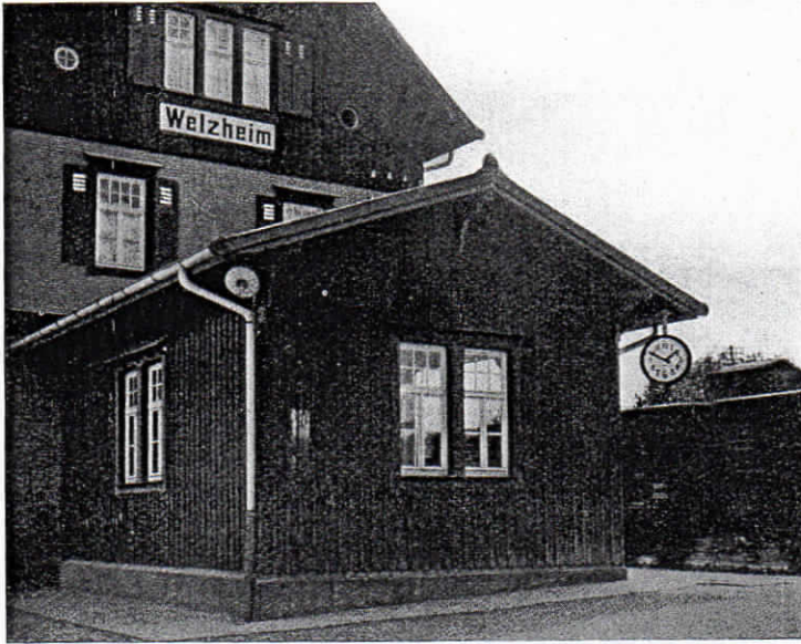
Abb. 34. Doppelseitige Normalzeit-Nebenuhr am Bahnhofsgebäude Welzheim (Württemberg)
