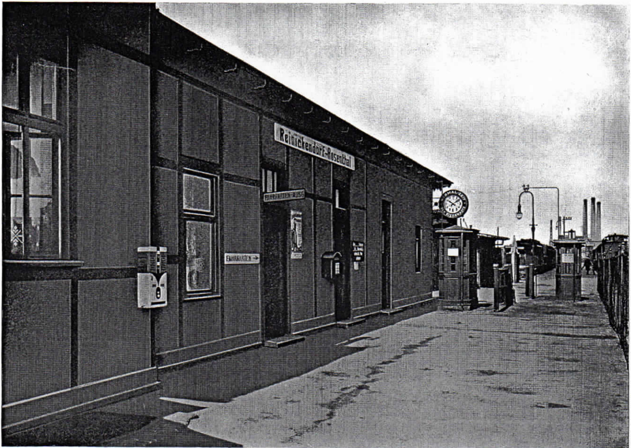
Abb. 20. Stationsgebäude der Reinickendorf-Rosenthal-Bahn mit transparenter, doppelseitiger Normalzeit-Außenuhr
