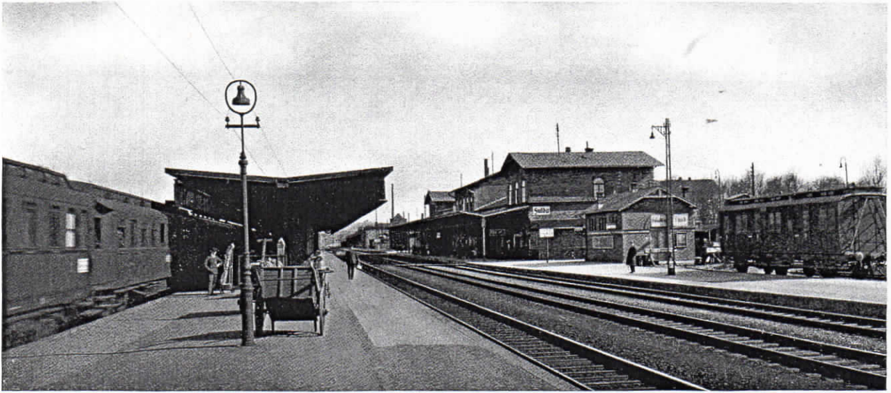
Abb. 3. Empfangsgebäude Fulda mit Bahnsteig
