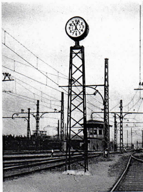
Abb. 37. Freistehende doppelseitige Normalzeit-Nebenuhr der Eisenbahn-Betriebs-Werkstätte Ohlsdorf
