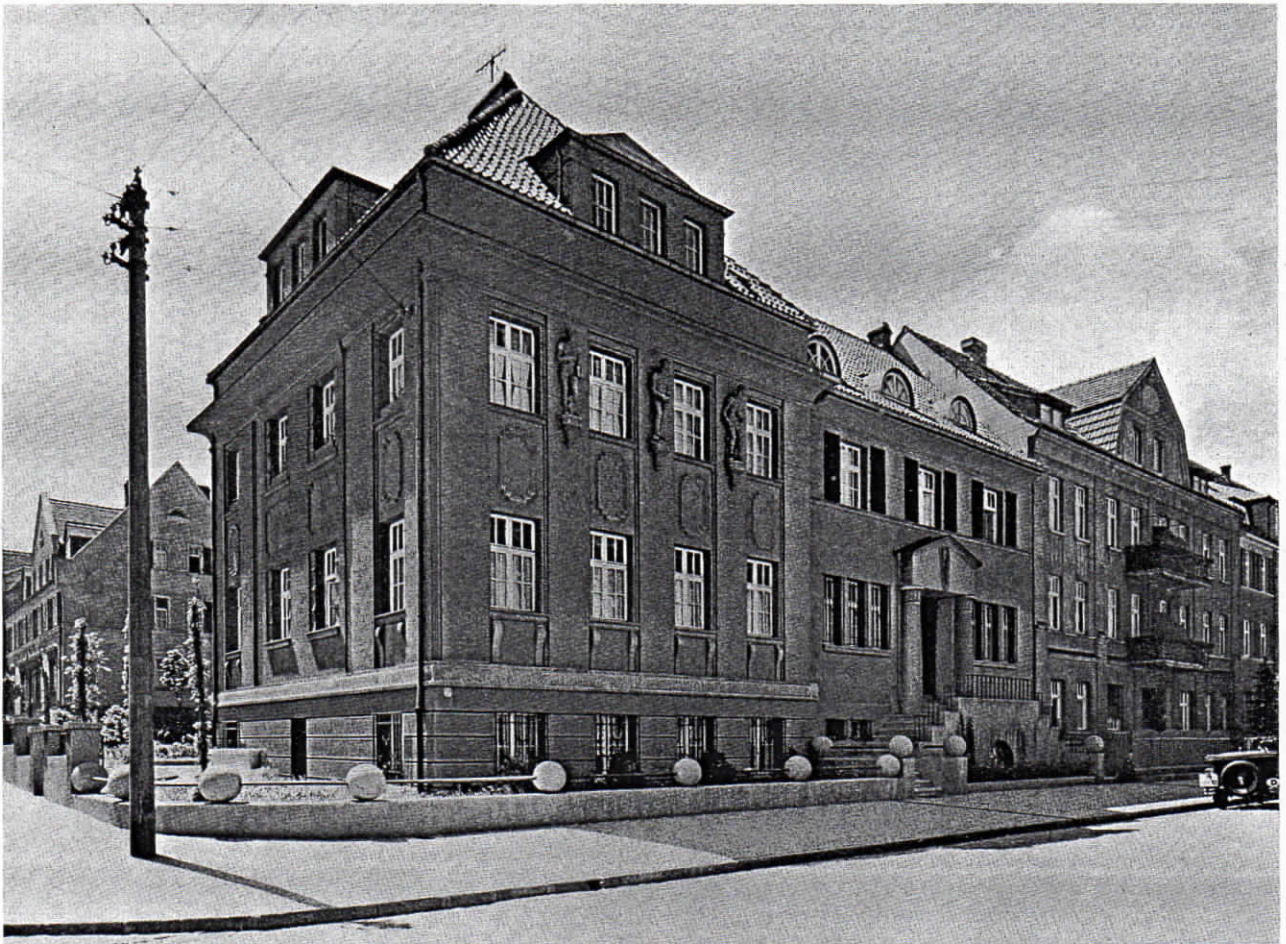
Abb. 25. Verwaltungsgebäude der Kleinbahn des Kreises Jerichow II in Burg bei Magdeburg
