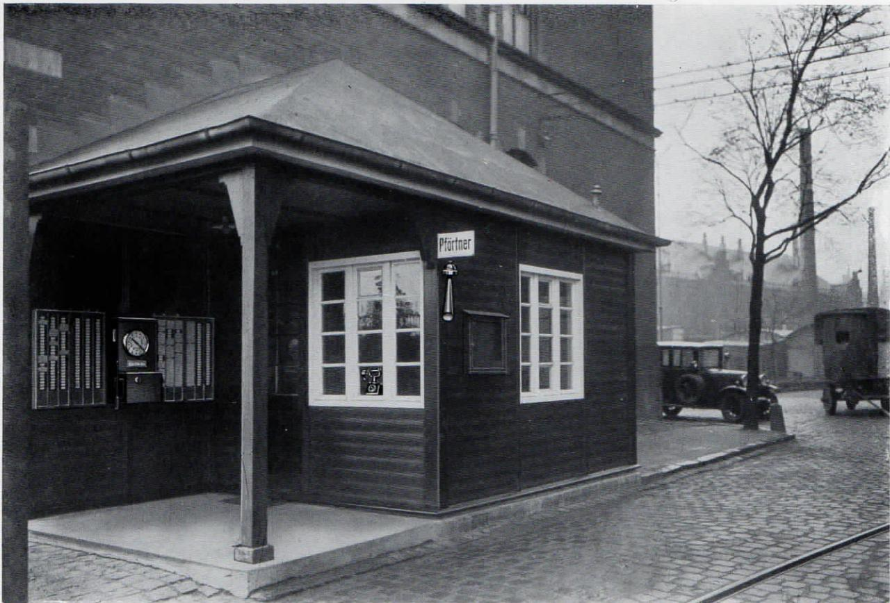
Abb. 9. Pförtnerhäuschen mit „Fuld“-Fernsprechapparat, Arbeitszeitkontrollanlage und Hupe.
